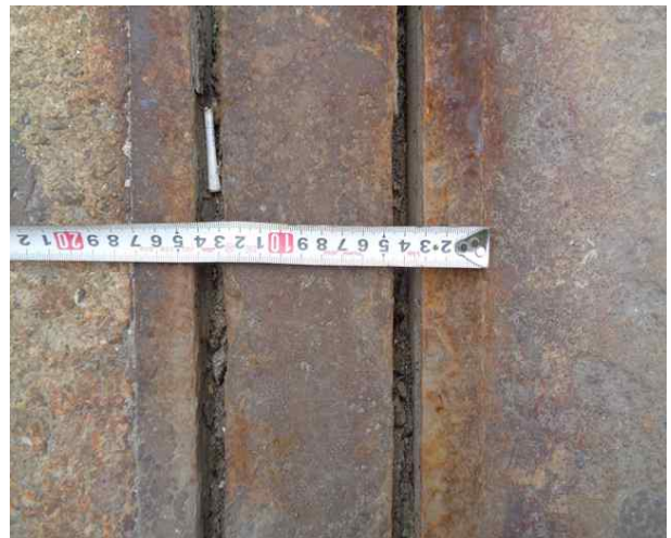
신축이음 유간 측정
