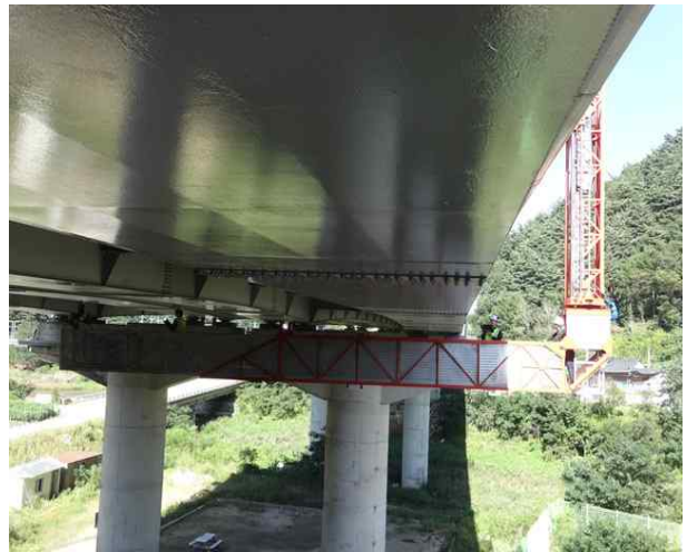
교량점검차를 이용한 근접조사
